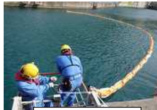
シルトフェンス設置
